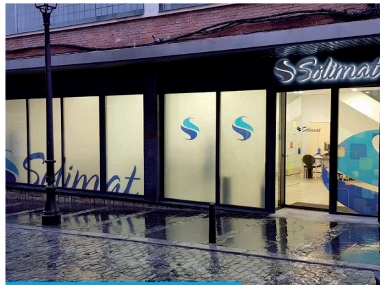
Nuevo Centro Administrativo Solimat Ávila
